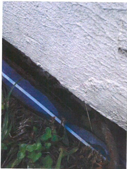
Relevé d'étanchéité
