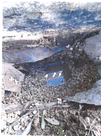
Mise en eau platine d'évacuation
