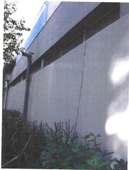
Ressortie d'eau en façade
