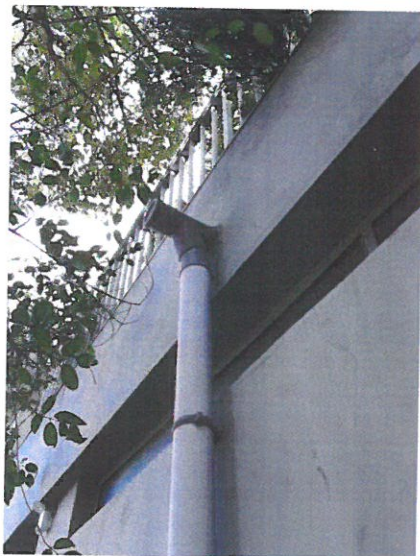
Ressortie d'eau en façade
