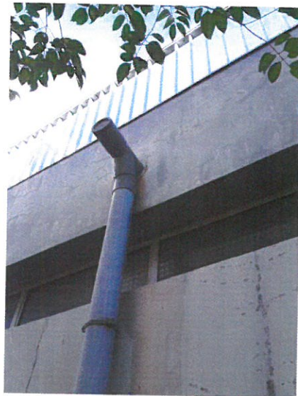
Ressortie d'eau en façade
