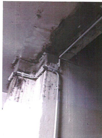
Ressortie d'eau dans les grages
