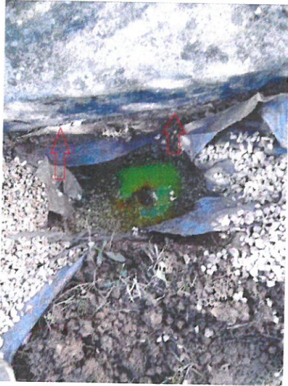
Mise en eau derrière étanchéité
