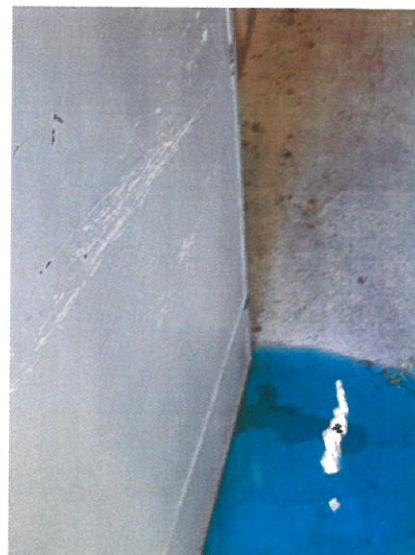
Ressortie d'eau dans les grages
