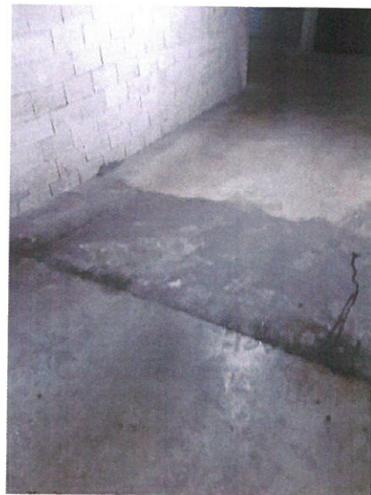
Ressortie d'eau garages
