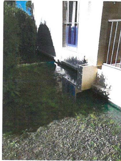
Zone mise en eau
