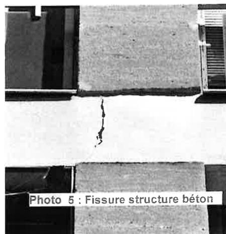
Photo 5 : Fissure structure béton
