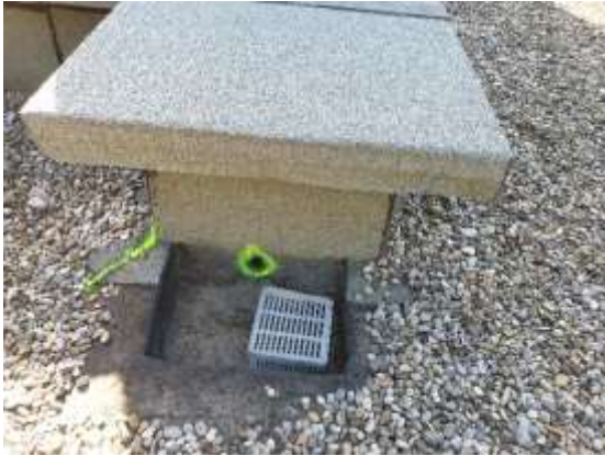
Evacuation toiture terrasse
