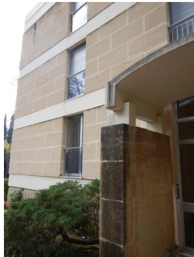
Façade principale de l'immeuble Le Grand Pin
