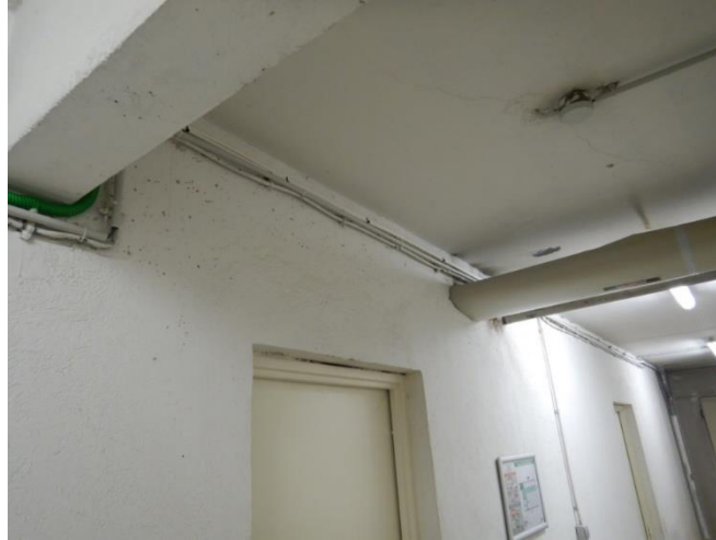
Plancher bas sur caves non isolé
