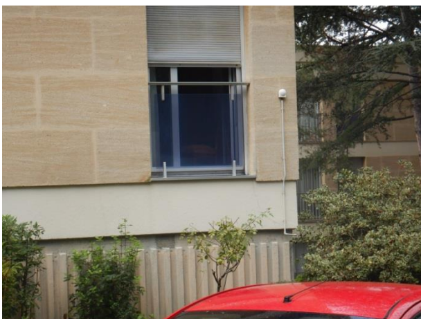
Sonde extérieure du bâtiment Olympia
