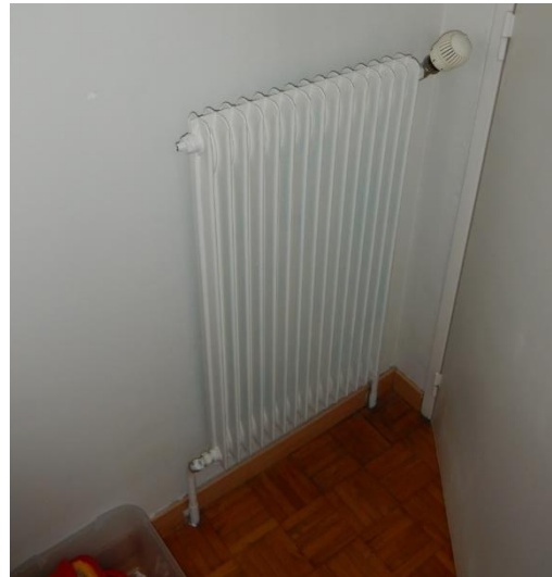
radiateur avec robinet thermostatique
